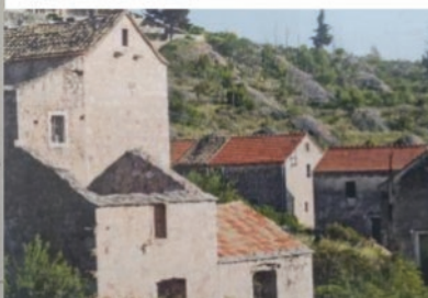
3) Razvoj kamene kuće, od jednostavne suhozidne prizemnice u kojoj zajedno žive ljudi i stoka, do kuće na dva poda s odvojenom kuhinjom, štalom i konobom (lijevo)
